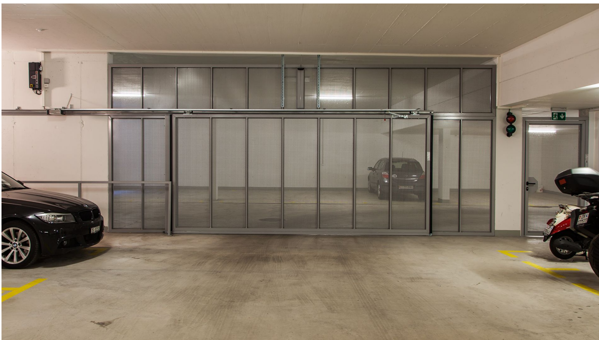
Sammelgaragentor Ansicht von innen. Mit Ampelsteuerung für optimale Sicherheit.
