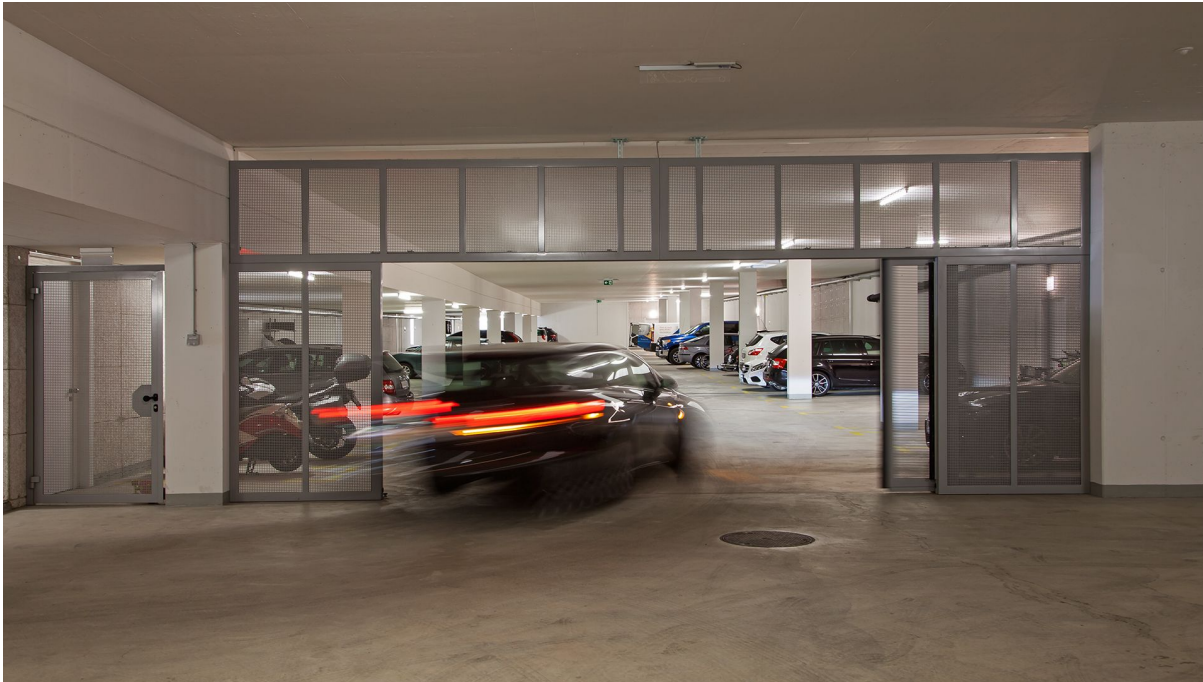
Sammelgaragentor Tiefgarage mit Ampelsteuerung
